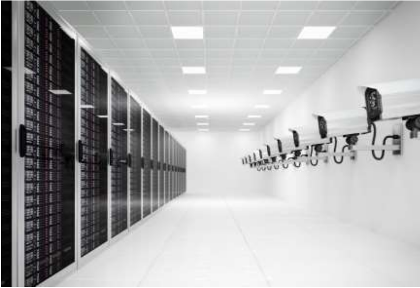
Gambar 4.9. Ilustrasi ruang server yang dilindungi CCTV (Sumber : https://cild.eu )
