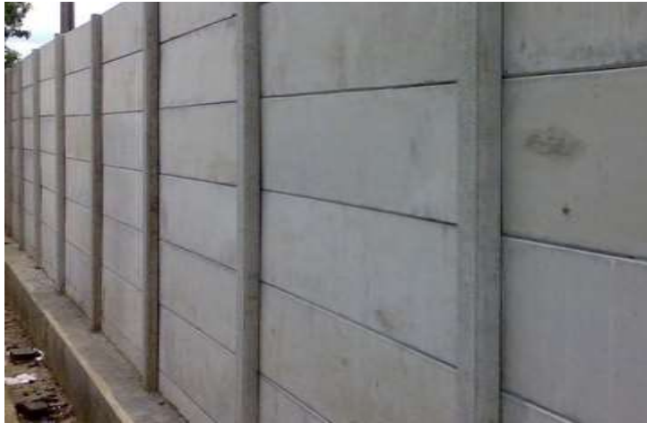
Gambar 4.4. Ilustrasi tembok pagar gedung data center. (Sumber : https://arkonsuperpanel.co.id )
