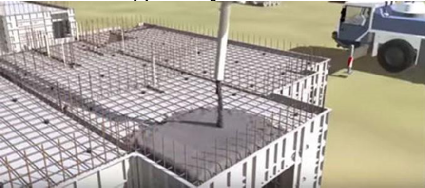
(c) Menuangkan beton
