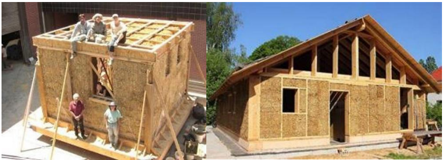
(a) Konstruksi rumah menggunakan jerami dan Produk akhir konstruksi.
