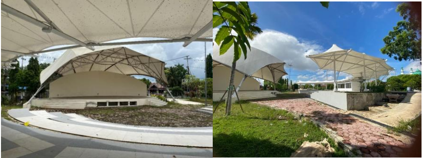
Gambar 6.9. Penambahan bidang pntl dibelakang panggung(kiri) dan undakan untuk meminimalisir kehilangan suara (kanan).
