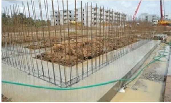
(a) Perkuatan dinding
