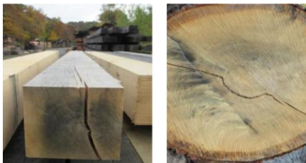
Gambar 9.3. Keretakan Alami Kayu
