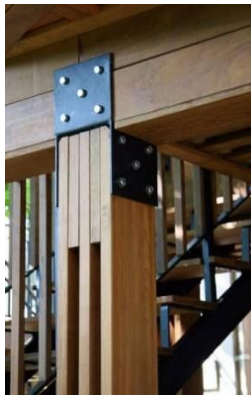
Gambar 7.4. Sambungan kolom berspasi dan balok (Sumber :Pinterest, Hledat googlem, Connecting wood beams)
