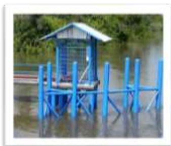
Gambar 5.1. Penyaringan Kasar pada Pompa Intake (PDAM-Ciamis, 2020)
