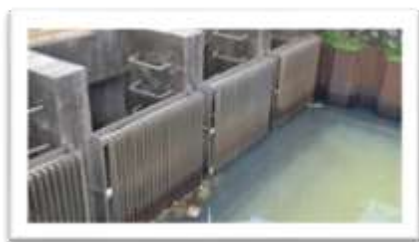
Gambar 5.1. Penyaringan Kasar pada Pompa Intake (PDAM-Ciamis, 2020)
