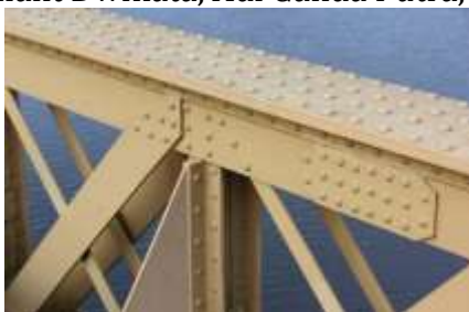
Gambar 6.16. Sambungan paku keling pada bidan miring
