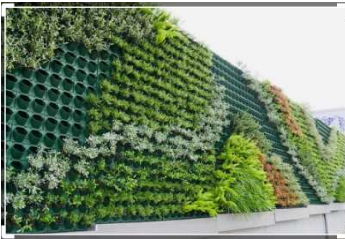
Gambar 8.8 : Vertical Garden dengan menggunakan system kantong
