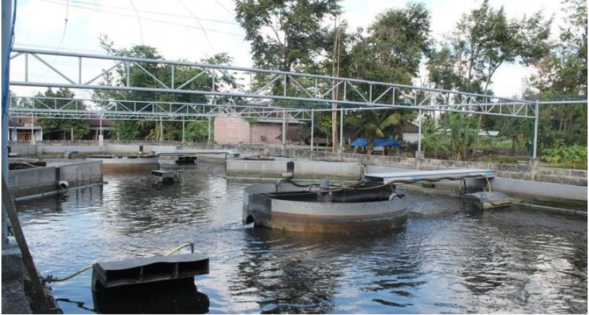
Gambar 8.1. Teknologi Recirculation Aquaculture System (RAS). Sumber : De Heus, 2023.
