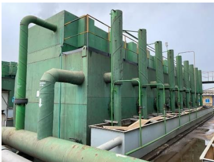
Gambar 3.5. Instalasi pengolahan air dan air limbah dengan unit koagulasi flokulasi (sumber: dokumentasi pribadi)
