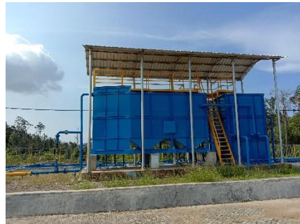
Gambar 3.5. Instalasi pengolahan air dan air limbah dengan unit koagulasi flokulasi (sumber: dokumentasi pribadi)
