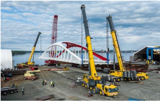
Gambar 2.12. Penggunaan crane modern dalam pekerjaan pembanguna jembatan
