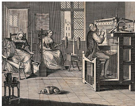
Gambar 2.10. Pemintalan benang dan alat tenun bukan mesin ( https://www.britannica.com )
