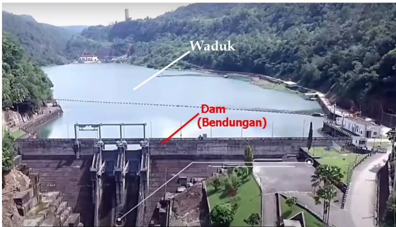
Gambar 3.2. Waduk dan Dam (Sumber PLTA Sigura-Gura Asahan)
