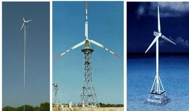
Gambar 10.9. Tower PLTB (kiri) Guyed (Tengah) Lattice (kanan) Mono-structure
