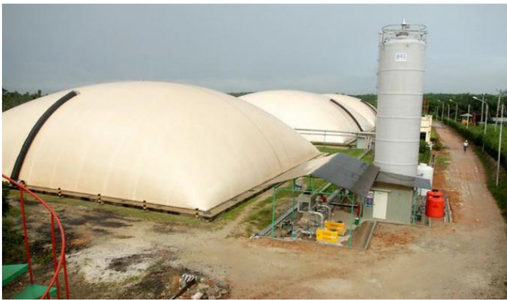
Gambar 10.4. Biopower dari Palm Oil Mills Effluent (Sumber: (Hutrindo, 2015))
