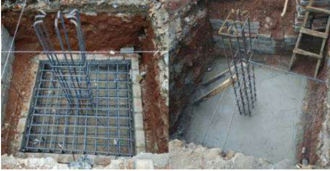
Gambar 4.5. Ilustrasi pondasi setempat/footplat (Sumber: lamudi.co.id, 2024)
