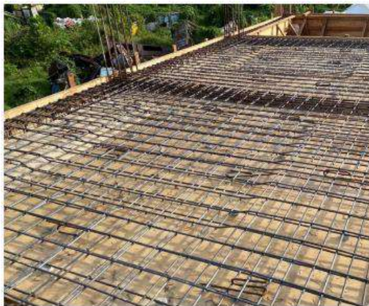
Gambar 4.21. Plat beton bertulang (Sumber : Siwu dkk, 2024)
