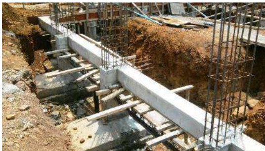
Gambar 4.9. Ilustrasi sloof struktur (Sumber : griyadepo.com , 2024)
