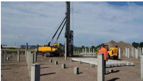
Gambar 4.6. Ilustrasi pondasi tiang pancang (Sumber : asiacon.co.id, 2024)
