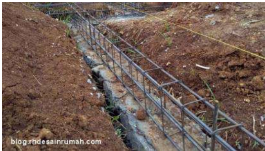
Gambar 4.8. Ilustrasi sloof praktis (Sumber : blog.rhdesainrumah.com , 2024)
