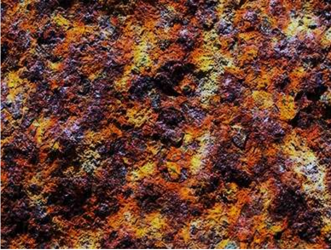
Gambar 3.10. Baja mengalami korosi
