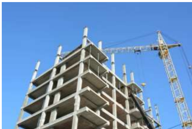
Gambar 1. 1. Proyek Konstruksi Bangunan Gedung (Sumber : Jhontraktor, 2024)
