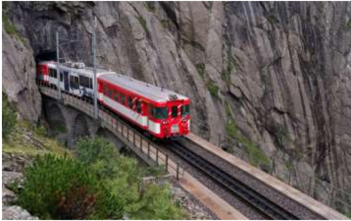
Gambar 4. 4. Terowongan Kereta Api Terpanjang di Dunia (Sumber : Patnistik, E, 2024)
