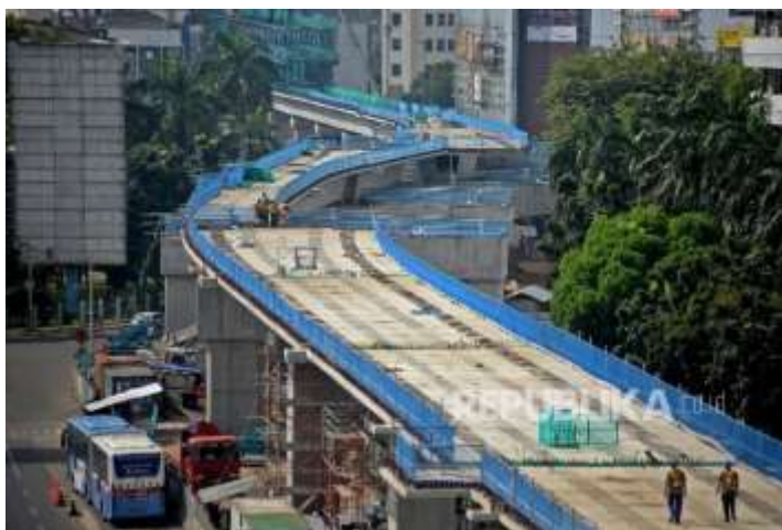
Gambar 4. 6. Pembangunan Proyek MRT Dikebut (Sumber : Zuraya, N, 2017)
