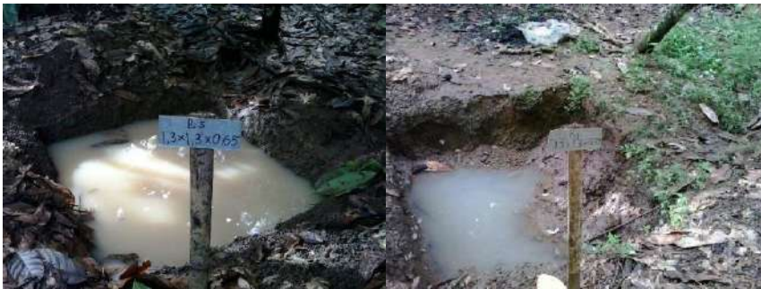
Gambar 6. 6. Lubang penampungan air yang berfungsi untuk menahan Aliran permukaan dan sedimentasi (Suhardi et al., 2017).
