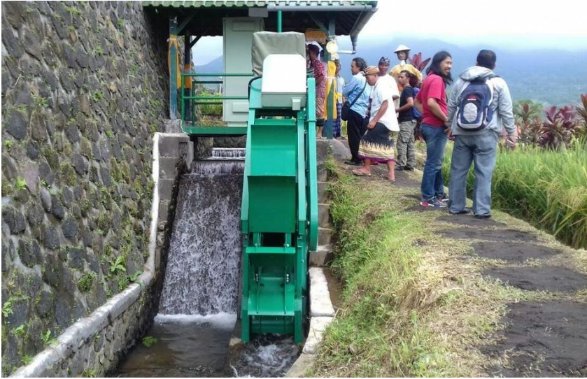
Gambar 5.2. Pembangkit Listrik tenaga air mikrohidro di pedesaan
