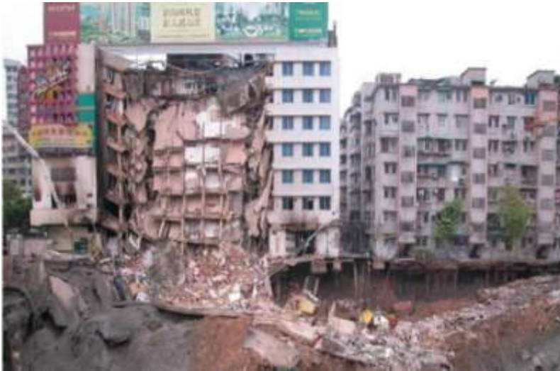
Gambar 7.8. Keruntuhan struktur bangunan eksisting di sebelah galian. (Sumber : Chen et al, 2006)
