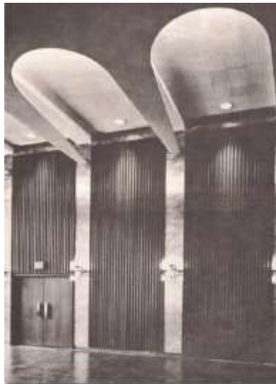
Gambar 2. 4 Lapisan Galar/Irisan Kayu Di Auditorium Serbaguna Montreal, +Liasoph Dan /Erkowitz Karya Arsitek L.L. Doelle.
