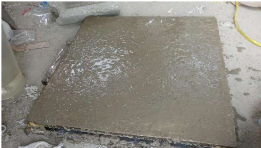
Gambar 4. 6 Proses pengeringan beton
