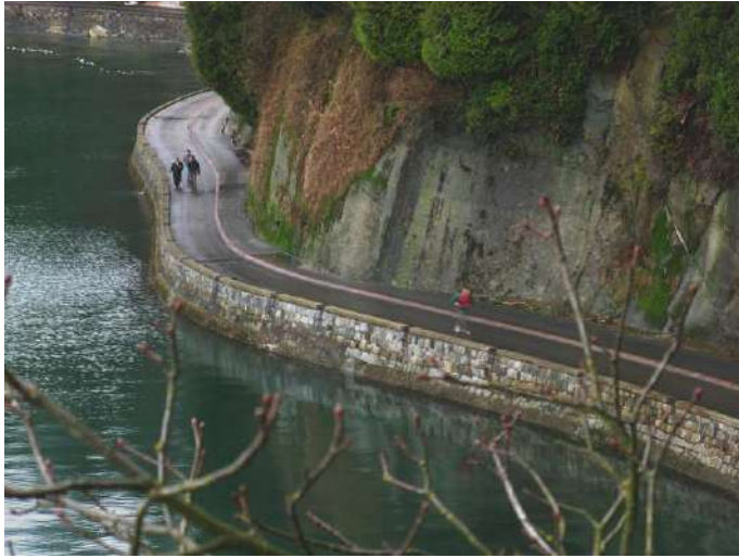
Gambar 7.2. Tembok laut di Vancouver Sumber : https://surl.li/bwfuep
