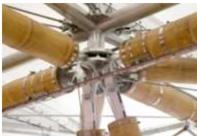
Gambar 5. 15. Sistem sambungan konstruksi bambu modern Sumber: (Ironbark Architecture, 2017)
