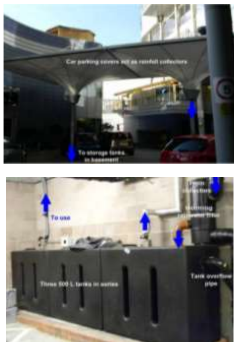
Gambar 3. 27. Panen air hujan dengan atap parkir Sumber: (Styles, Schönberger, & Martos, 2013)
