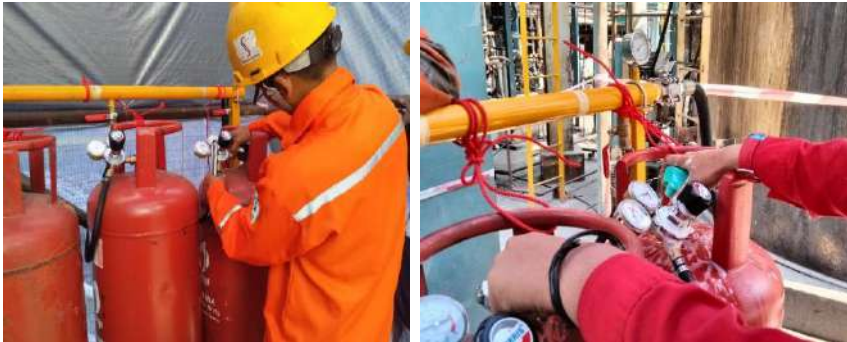
Gambar 5. 14. Instalasi Bahan bakar serta pengecekan kebocoran
