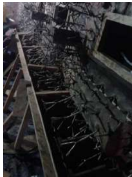
Gambar 4. 7. Pemasangan anchor
