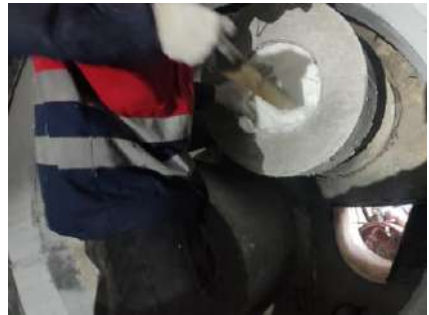
Gambar 5. 10. Gambar ( a ) Salah satu pengaplikasian blanket untuk melindungi tools atau material dari panas yang berlebih. Gambar (b) pengaplikasian blanket untuk terhindar dari heat loss yaitu menutup lubang keluaran .
