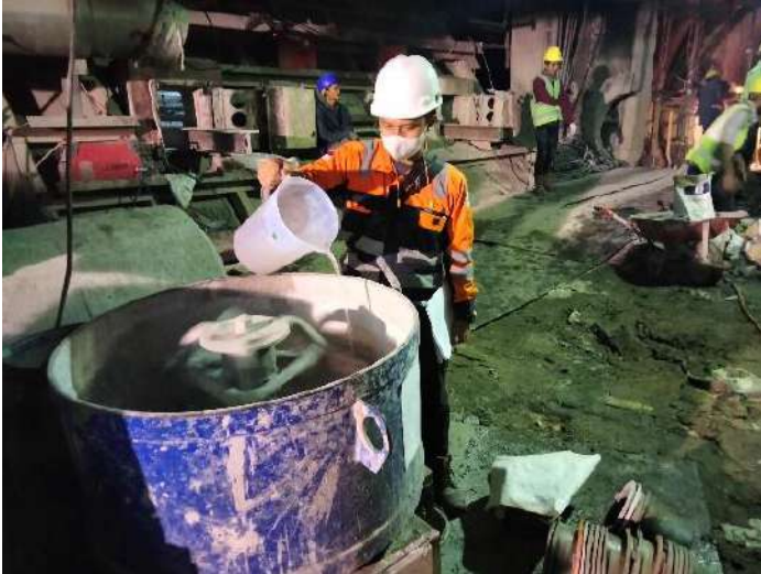
Gambar 4. 5. Pencampuran castable
