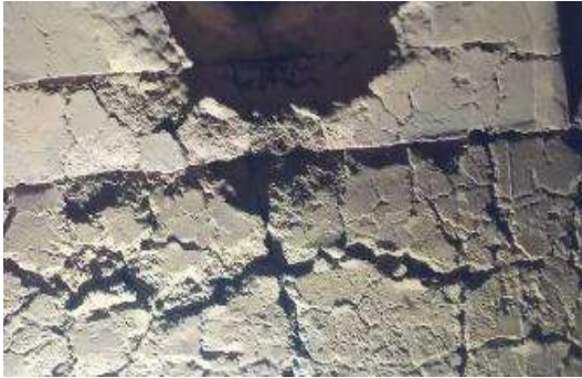
Gambar 3. 3. Retakan Pada Refraktori
