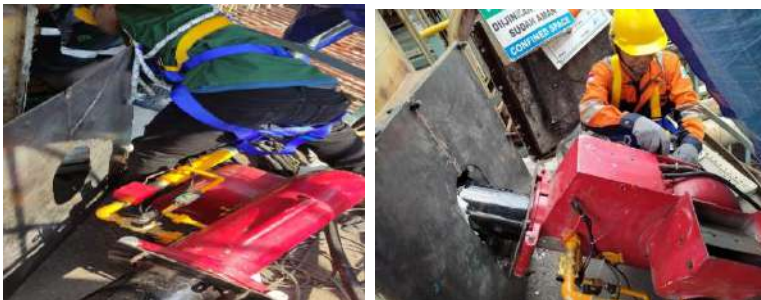
Gambar 5. 12. Proses installasi Burner external di lapangan
