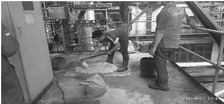
Gambar 3. 8. Proses yang salah pengadukan Castable
