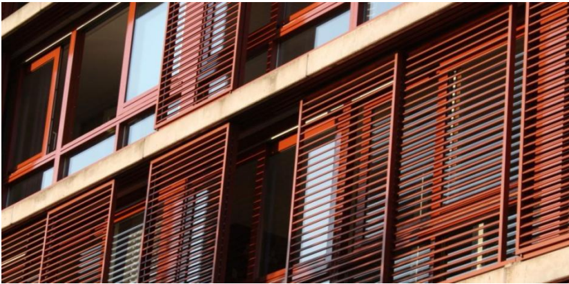
Gambar 3. 3 Bentuk Peneduh Statis berbentuk Louver
