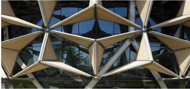
Gambar 3. 4 Bentuk Peneduh Dinamis di Menara Al-Bahr, Uni Emirat Arab
