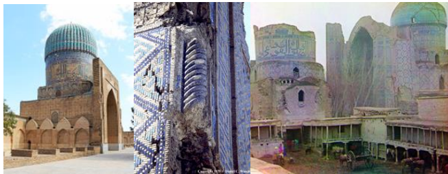
Gambar 5. 9. Masjid Bibi Khanym di Kota Samarkand sebelum direnovasi dan setelah direnovasi
