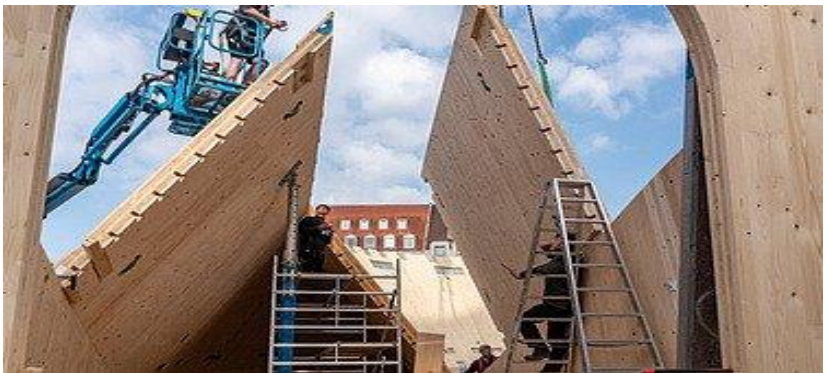
Gambar 9.3. Pemanfaatan kayu berlaminasi silang pada konstruksi bangunan
