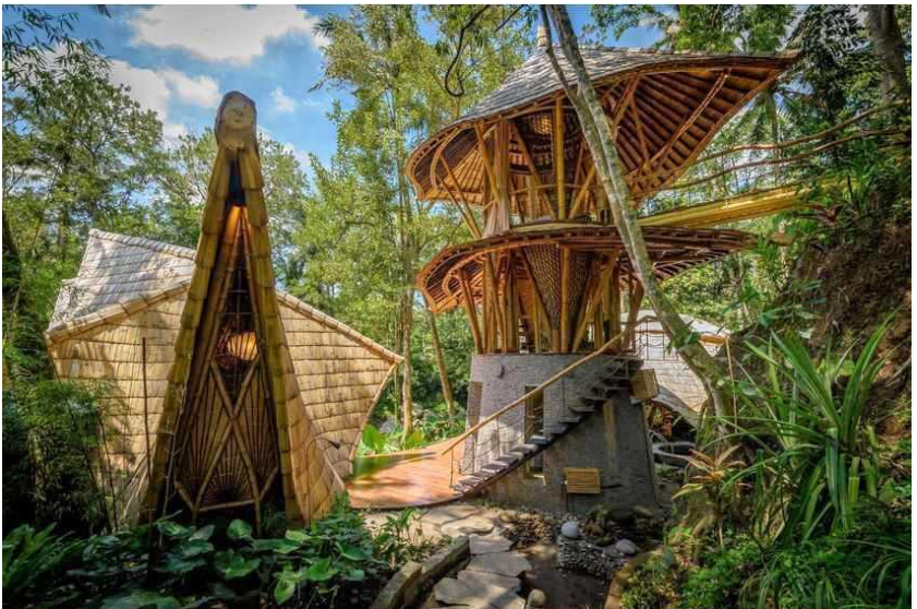
Gambar 9.1. Pemanfaatan bambu sebagai bahan bangunan
