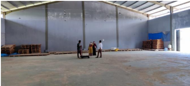
Gambar 19. Ruang Penyortiran rumput laut kering dalam Agroindustri
