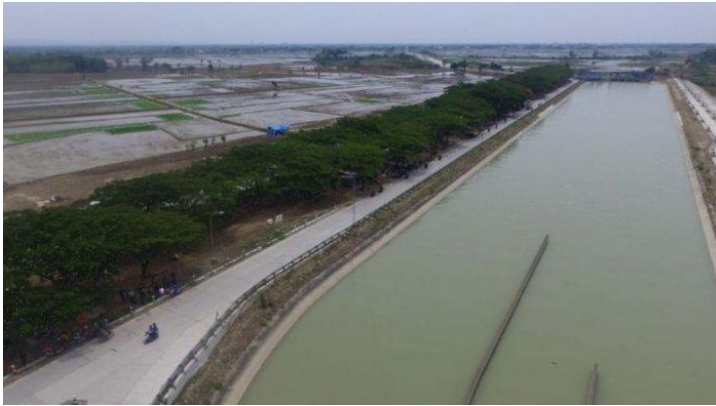
Gambar 9.5 Irigasi Waduk Kedungombo (Galih, 2018)
